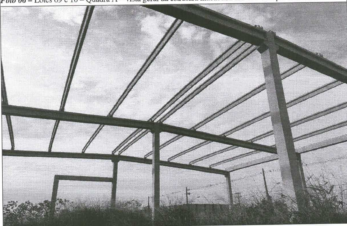
Foto 06 – Lotes 09 e 10 – Quadra A – vista geral da estrutura inacabada em concreto pré-fabricado
