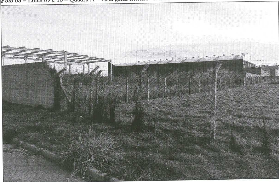
Foto 08 – Lotes 09 e 10 – Quadra A – vista geral externa - fundos
