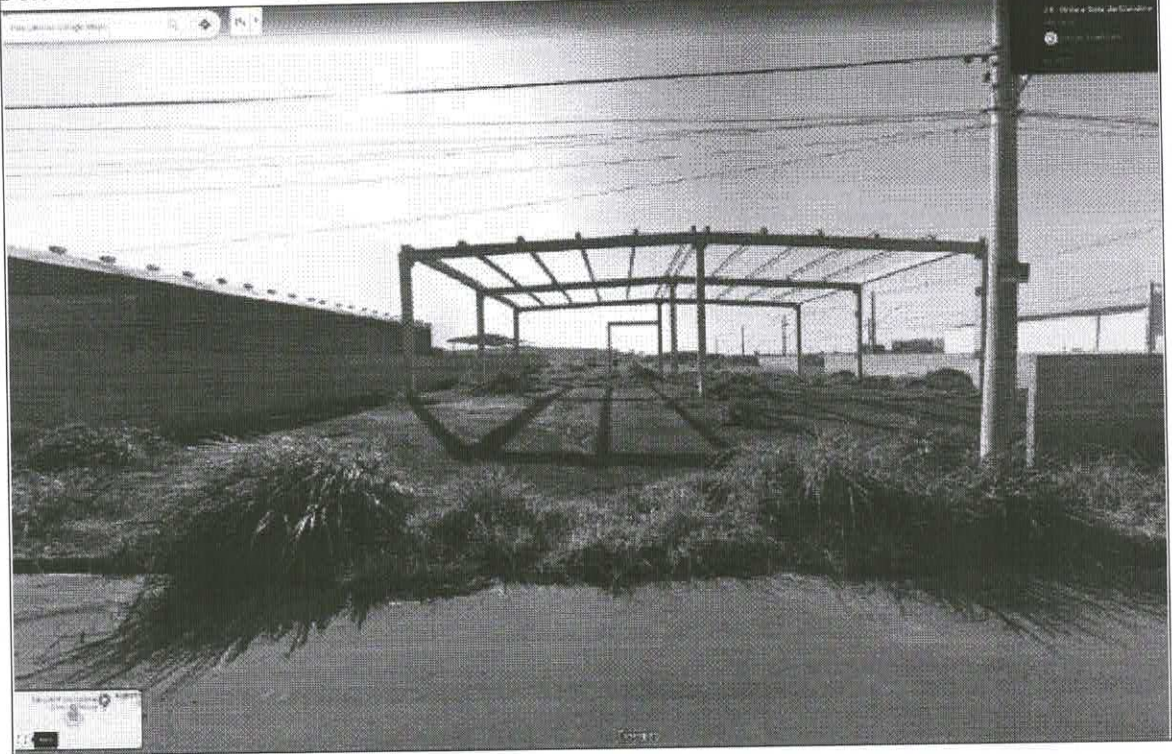
Foto 01 – Lotes 09 e 10 – Quadra A – vista geral externa – frente – imagem Google – julho/2022
