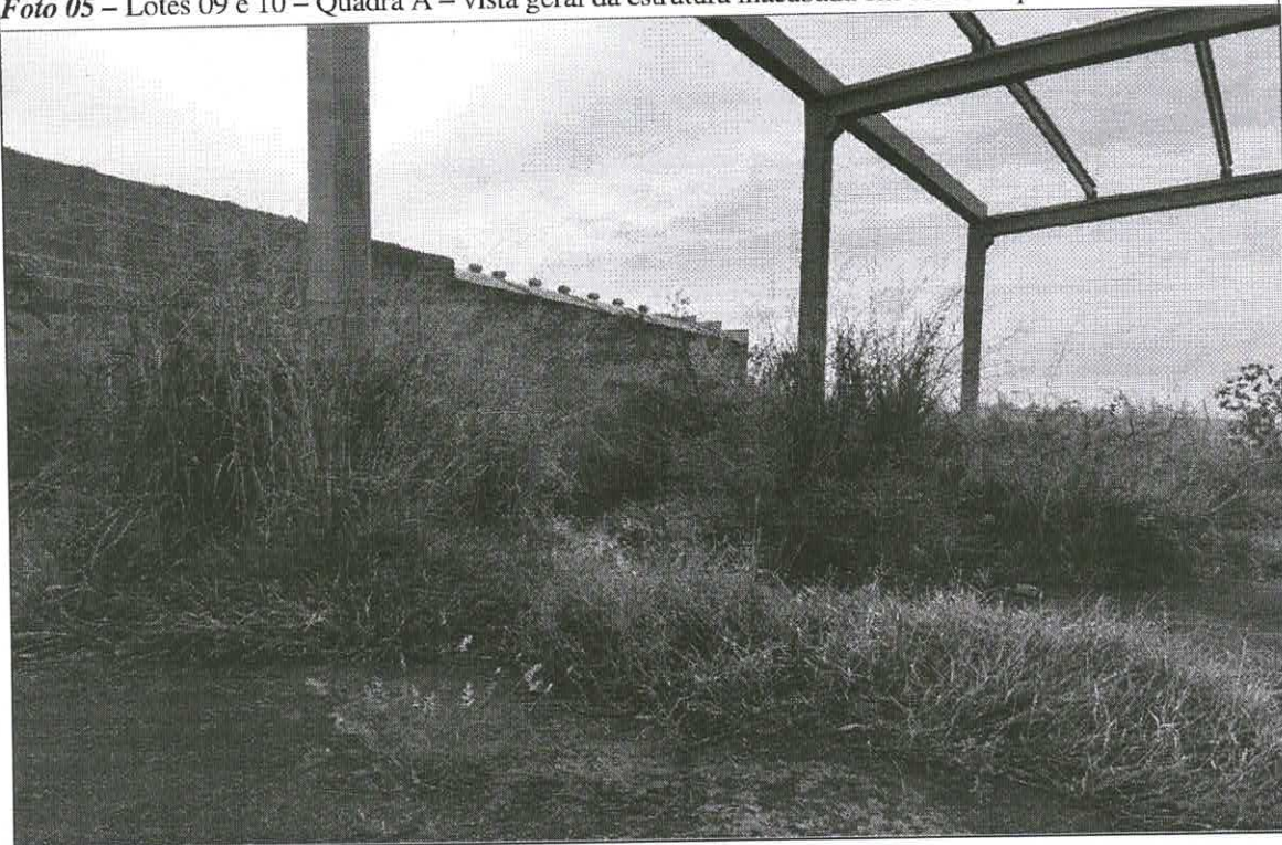
Foto 05 – Lotes 09 e 10 – Quadra A – vista geral da estrutura inacabada em concreto pré-fabricado
