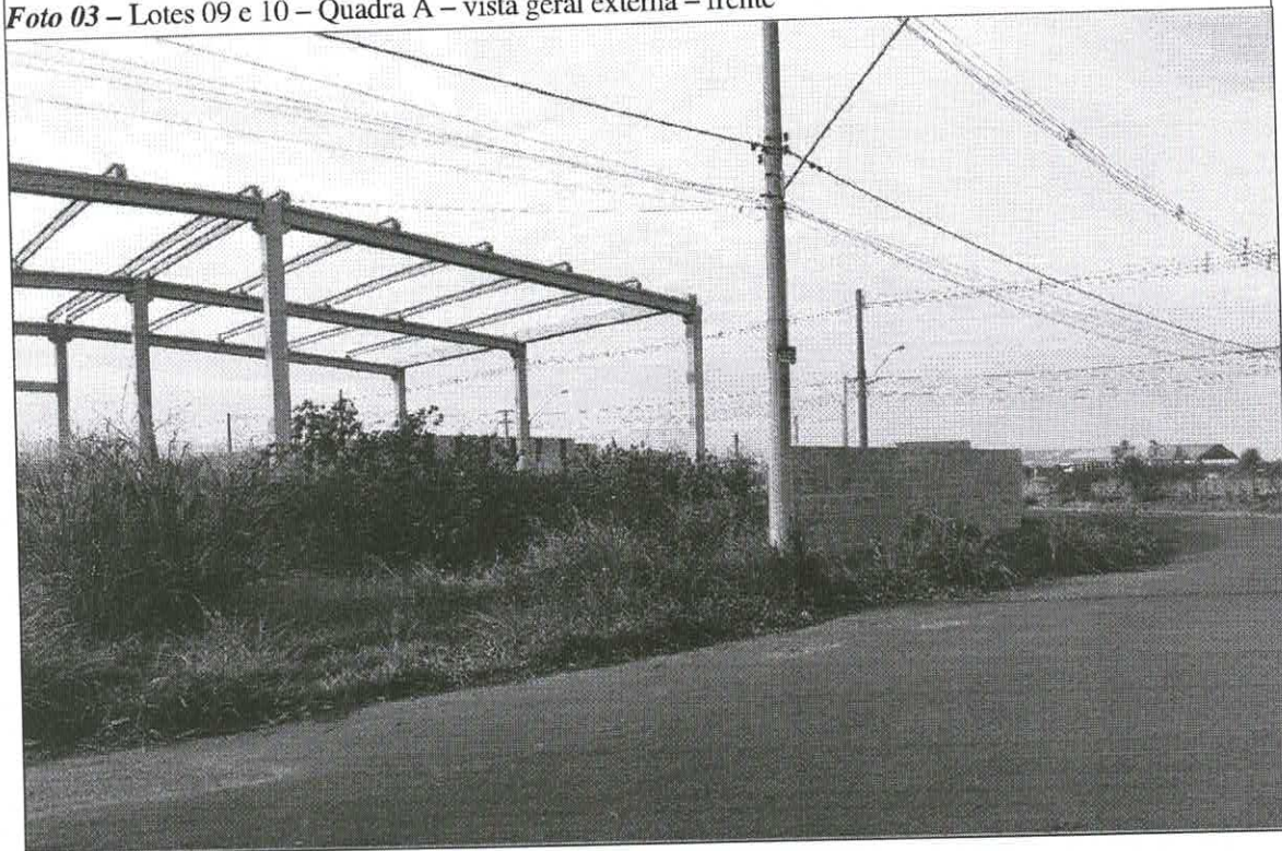
Foto 04 – Lotes 09 e 10 – Quadra A – vista geral da estrutura inacabada em concreto pré-fabricado
