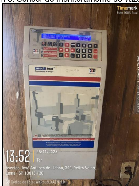
Imagem 8. Sensor de monitoramento de vazamentos
