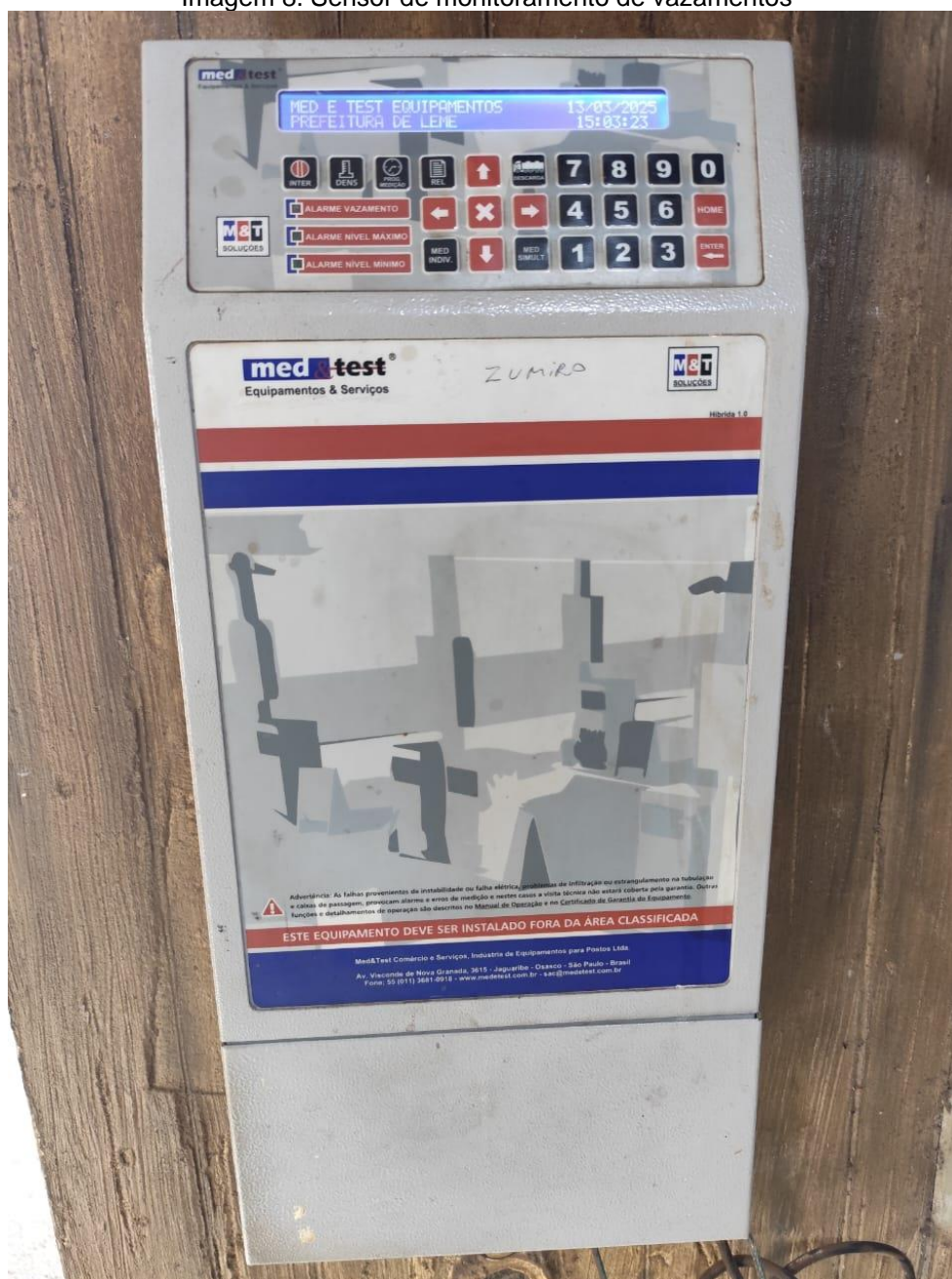
Imagem 8. Sensor de monitoramento de vazamentos
