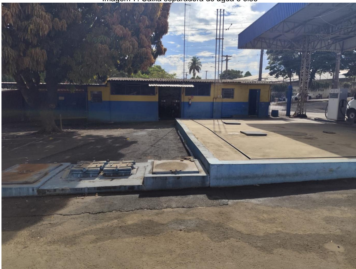
Imagem 7. Caixa separadora de água e óleo
