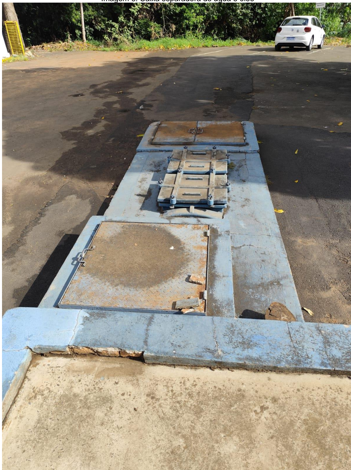
Imagem 6. Caixa separadora de água e óleo
