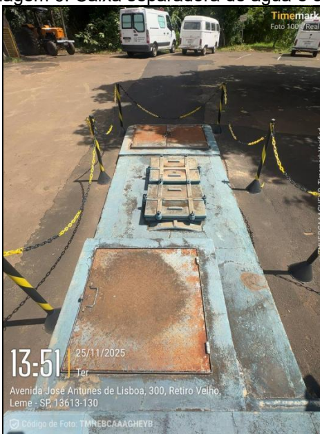
Imagem 6. Caixa separadora de água e óleo
